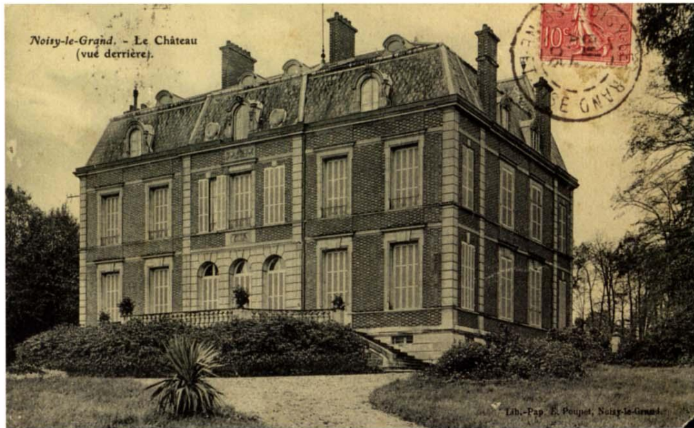
20 | Château Périac, façade principale, sud. Avant 1904.
