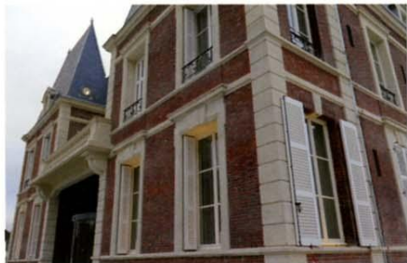
18 | La façade de l'hôtel de ville après la restauration.
